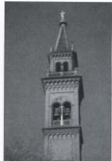
Foto 1. Campanile della Chiesa di San Bernardino fuori le mura.
