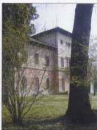
Foto 2. Facciata dal giardino.
