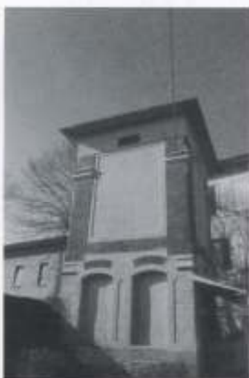
Foto 9. Cabina elettrica in via Kennedy.
