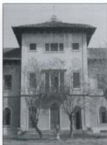
Foto 4. L'avancorpo centrale sopraelevato.
