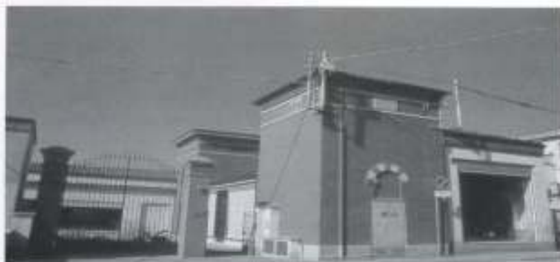
Foto 8. Cabina elettrica in via Stazione.
