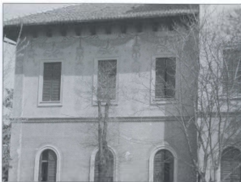
Foto 11. Decorazione della facciata, parte sinistra.
