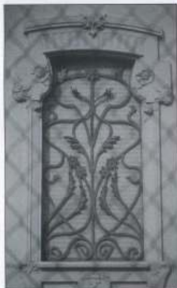
Foto 11. Riquadro in cemento e inferriata floreali (Via Brescia, 4).
