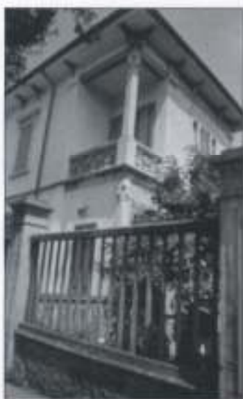
Foto 3. Balcone e recinzione in cemento (Via Diaz, 133).
