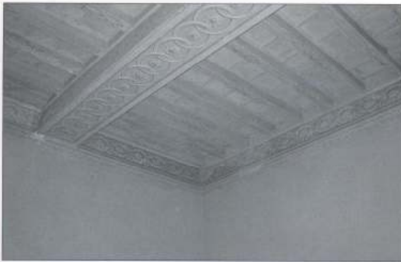
Foto 16. Soffitto del salone principale del primo piano.
