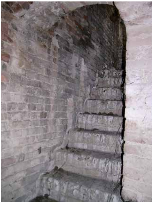
↳ Resti della scala di accesso allo spalto.
