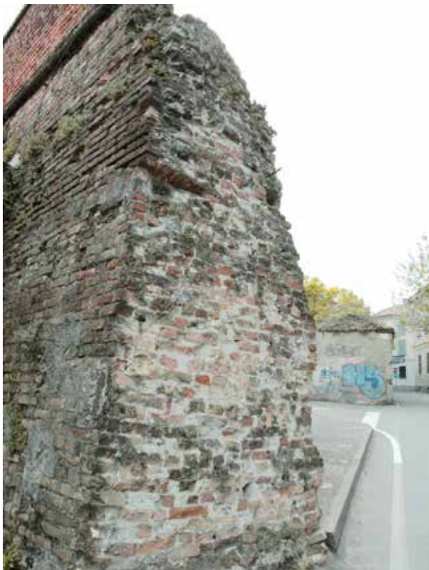
↳ Sbrecciamento delle mura in via Pesadori.
