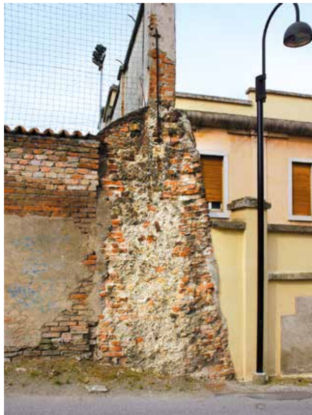
└ Sbrecciamento di via Valera.
