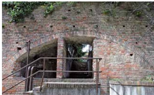
↳ Particolare dei passaggi.
