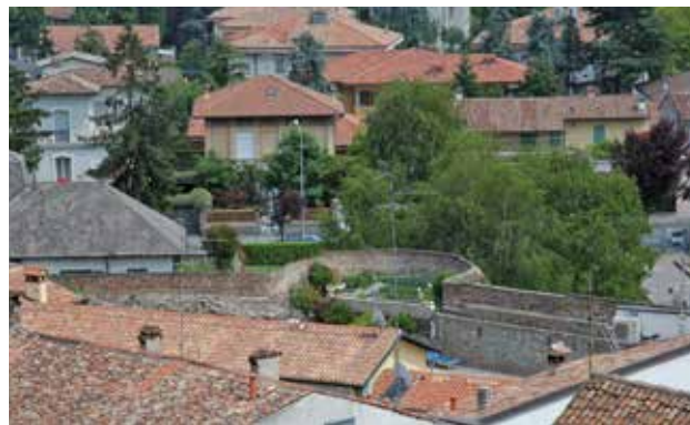
↳ Vista dall'interno Torrione San Marco.
