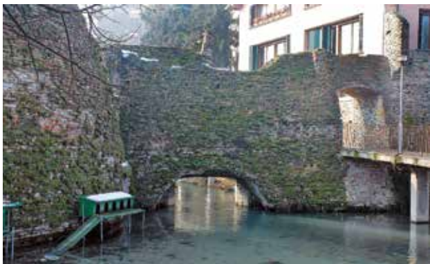
↳ Passaggio d'acqua sulla roggia Fontana.
