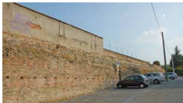
↳ Interno mura con sopralzo su via Pesadori.
