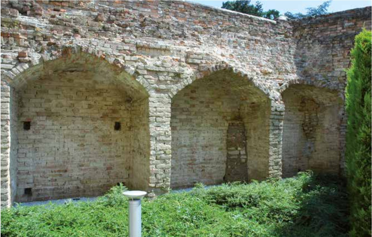
└─ Elementi costruttivi addossati alle mura.
