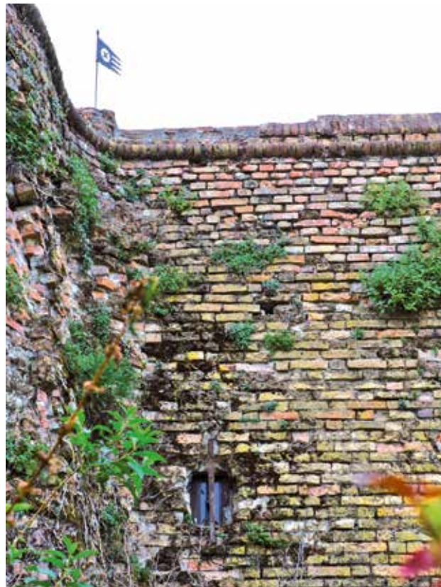
↳ Particolare Torrione San Marco.
